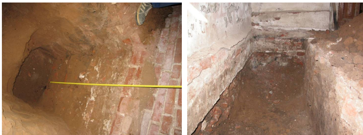
Рис. 4. Шурфы фундаментов гостиницы «Новомосковская»
