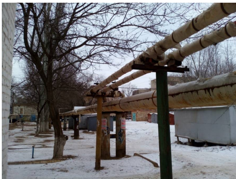
Рис. 2. Участок с качественной изоляцией
